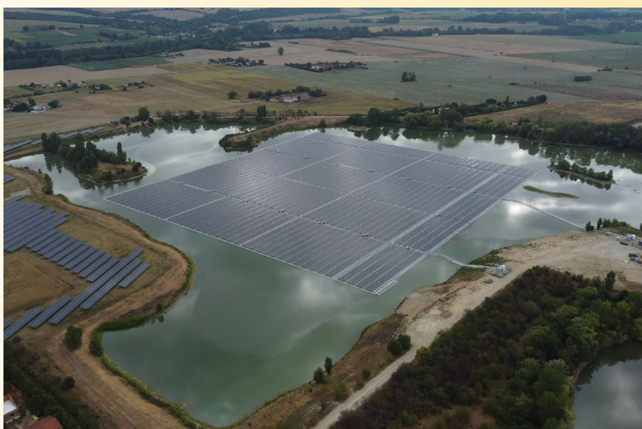
Photo aérienne d'une gravière équipée d'une centrale photovoltaïque flottante dans la vallée de la Garonne (centrale développée par Akuo).
